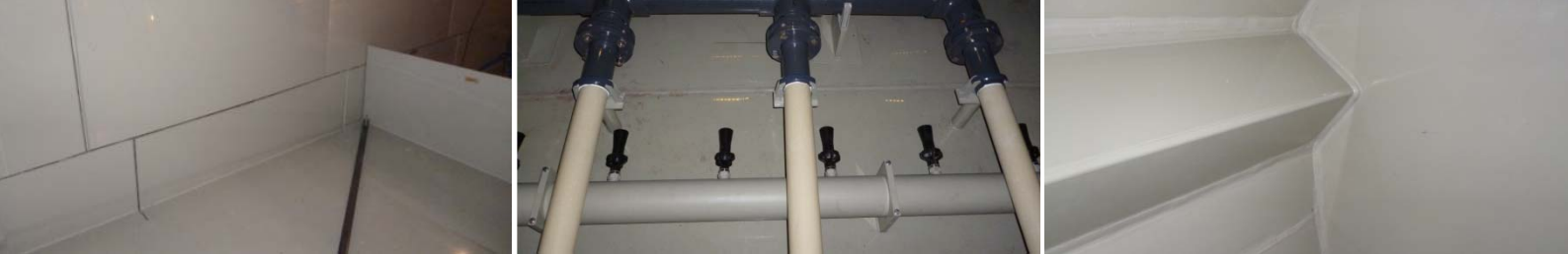
V. l. n. r.: Auskleidung mit SIMONA® PP AlphaPlus® Platten; Düsenrohre aus SIMONA® PP AlphaPlus® Rohren; sichere Schweißverbindungen mit SIMONA® PP AlphaPlus® Schweißdrähten.
